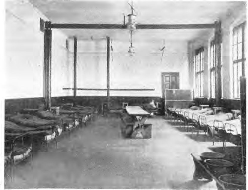
Schülerwanderherberge des Stadtschulrates für Wien in der Mädchenbürgerschule, I., Johannesgasse 4a, vom Jugendhilfswerk mit 34 Betten eingerichtet.
